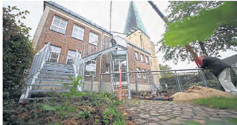
Die neue Fluchttreppe führt vom Saal im oberem Stockwerk des Pfarrheims St. Georg in den Pfarrgarten hinab.
